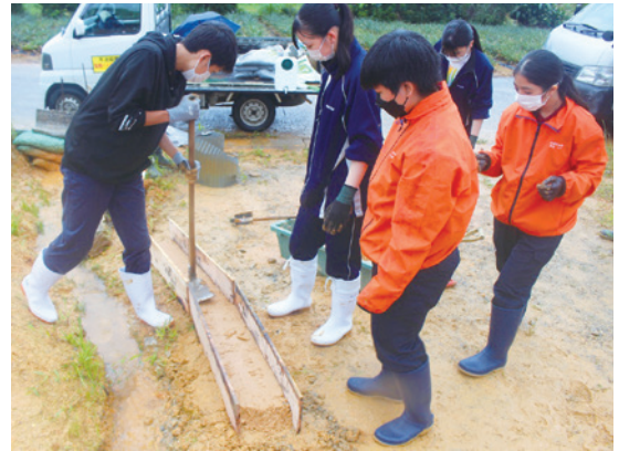
沖縄の農地で地元高校生と赤土流出を抑制する三和土の簡易堤防を設置。
